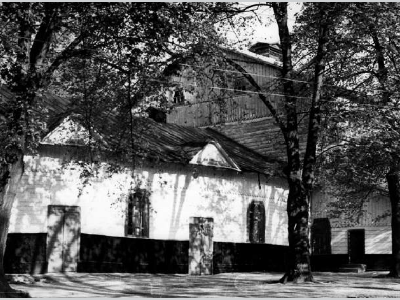
Приміщення театру у Ромнах (нині Сумська обл.), сер. XIX ст. Архітектор Василь Кричевський. Будівлю повністю знищила пожежа 2007 р. З фондів Державного історико-культурного заповідника "Посулля".
