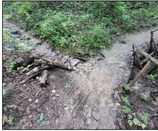
Рис. 18. Поступове замулення і руйнування стежки у місці її перетину яром Fig. 18. Gradual siltation and destruction of the trail at the point where it crosses a ravine
