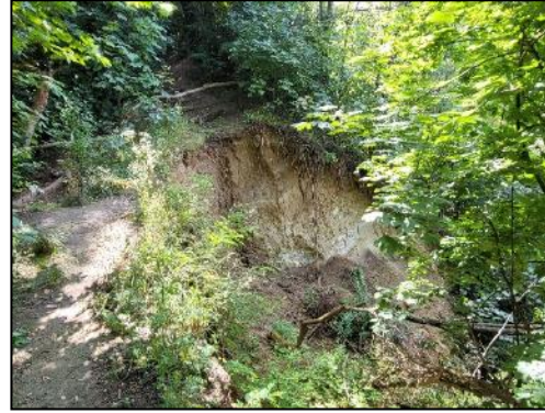
Рис. 16. Зруйнована ерозійними і зсувними процесами ділянка “Цісарської стежки”
