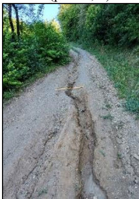
Рис. 1. Ерозійна вимоїна у лівому борті долини потоку, який дронує
