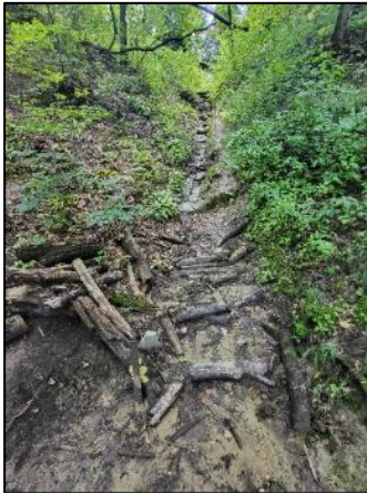
Рис. 17. Закладені поперек тальвегу яру дерев'яні бруси – приклад інженерних рішень, використаних під час регулювання стоку яру в парку “Знесіння”
