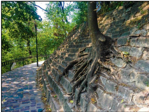
Рис. 11. Прокладена по терасованому схилу кургану доріжка і збудована вздовж неї підпірна стінка
