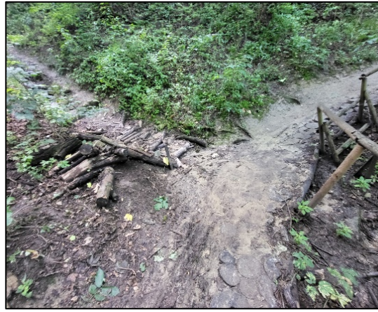
Рис. 18. Поступове замулення і руйнування стежки у місці її перетину яром
