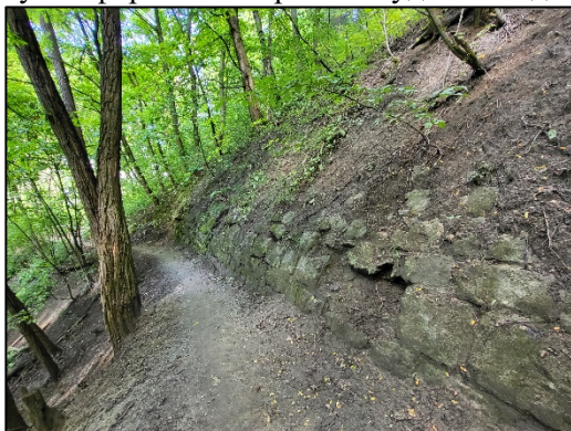
Рис. 14. Терасований схил і підпірна стінка, яку збудовано вздовж “Цісарської стежки” у парку “Знесіння”
