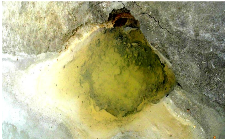
Рис. 12. Тампонування ділянок вилуговання й армування уламками соляно-глинистих відвалів гідроізоляційного шару.
