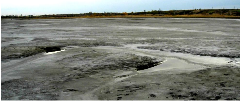
Рис. 11. Закарстованість приповерхневого шару секції № 1 Стебницького хвостосховища.
