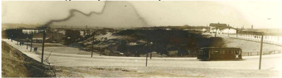
Рис. 10. Поворот колії Персенківка – Підгайці і вигляд на станцію Личаків (фото поч. XX ст., джерело: Станція Личаків..., 2020)
