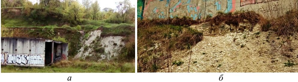
Рис. 11. Мергелі верхньокрейдного періоду у західному Кривчицькому кар'єрі: a – вигляд західної стінки кар'єру (знизу біліють мергелі, вище розташований уступ, утворений пісковиками і вапняками, ще вище залягають піски); б – відслонення зблизька: вгорі виходи міцних порід, внизу – осипний шлейф колювію
