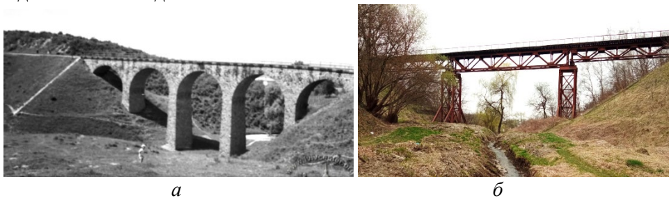
Рис. 7. Віадук з 5-ма арками поч. XX ст. (а) та міст поч. XXI ст. (б) Fig. 7. (a) The viaduct with 5 arches built at the start of XX century (b) and the modern bridge rebuilt at the start of XXI century
