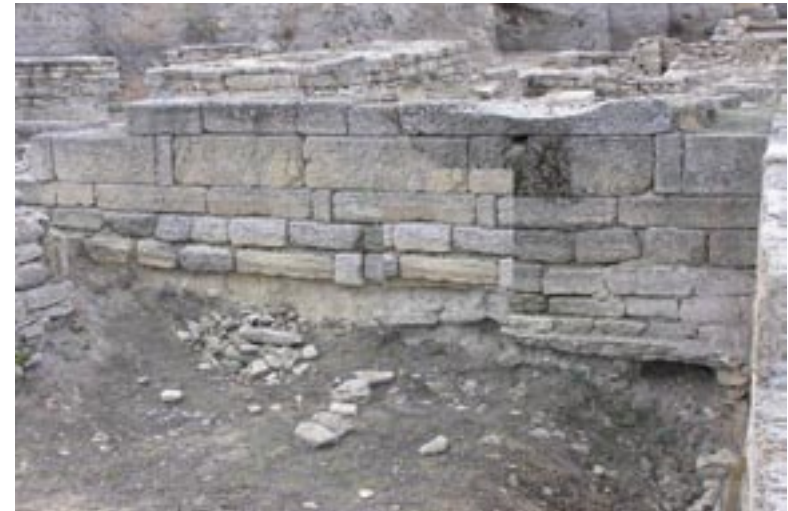
Фото 47. Тіра. Оборонна стіна № 282. Східний фасад. Photo 47. Tyras. Defensive wall № 282. East facade.
