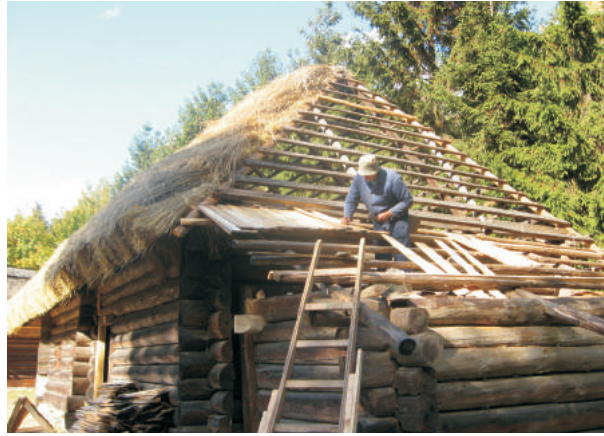
Фото 43: Хата кінця XIX ст. зі с. Липовиці Рожнятівського р-ну Івано-Франківської обл. Процес покриття даху колоатою дошкою. Експозиція НМНАПУ, 2009 р. Фото М. Магійчука
