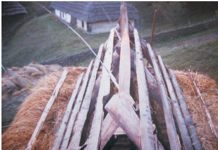
Фото 33: Фрагмент даху млина зі с. Пилипця Міжгірського р-ну Закарпатської обл. Процес покриття даху соломною “внатрус”. Реставрація 2006 р., НМНАПУ, м. Київ. Фото М. Матійчука
