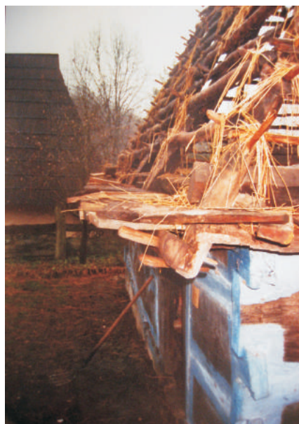
Фото 36: Хата XVII–XVIII ст. зі с. Теремлі Тячівського р-ну Закарпатської обл. Фрагмент каркасу даху, підготовленого до покриття соломною “внатрус”. Реставрація 2006 р., НМНАПУ, м. Київ. Фото М. Матійчука
