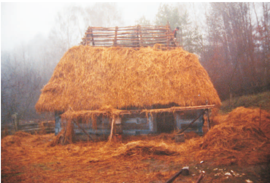
Фото 37: Хата XVII–XVIII ст. зі с. Терелі Тячівського р-ну Закарпатської обл. Покриття даху соломною “внатрус”. Реставрація 2006 р., НМНАПУ, м. Київ. Фото М. Магійчука
