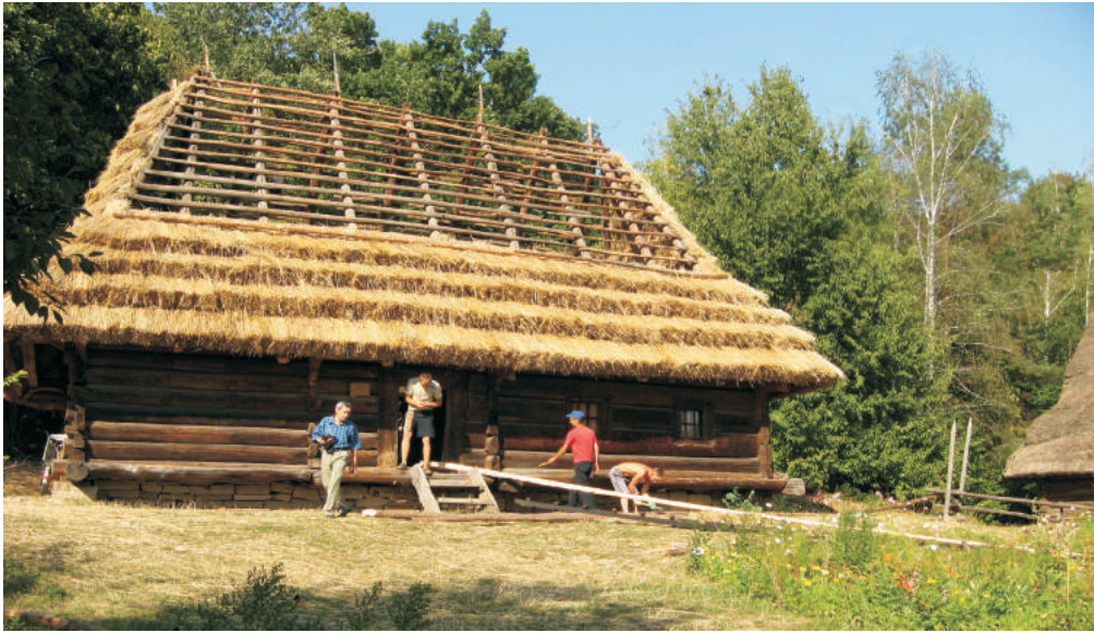
Фото 39: Хата 1841 р. зі с. Рекіт Міжгірського р-ну Закарпатської обл. Покриття даху “жупами”. Реставрація 2008 р., НМНАПУ, м. Київ. Фото М. Матійчука
