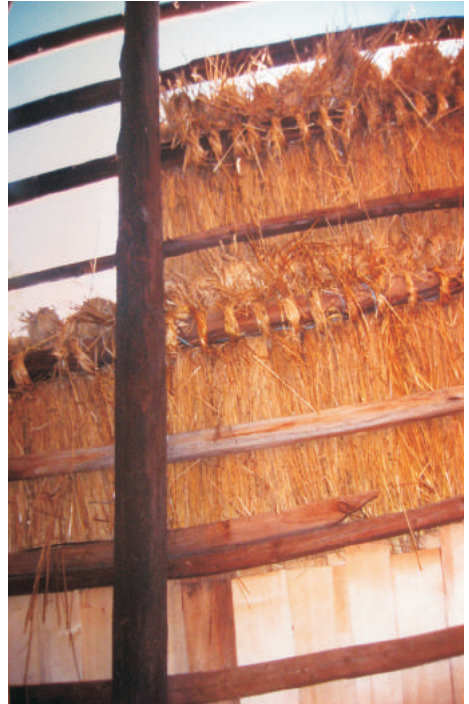
Фото 32: Фрагмент даху млина зі с. Пилипця Міжгірського р-ну Закарпатської обл. Процес покриття даху “жупами”. Реставрація 2006 р., НМНАПУ, м. Київ. Фото М. Матійчука
