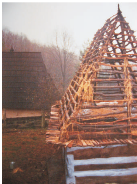
Фото 35: Хата XVII–XVIII ст. зі с. Теремлі Тячівського р-ну Закарпатської обл. Каркас даху, підготовлений до покриття соломною “внатрус”. Реставрація 2006 р., НМНАПУ, м. Київ. Фото М. Матійчука
