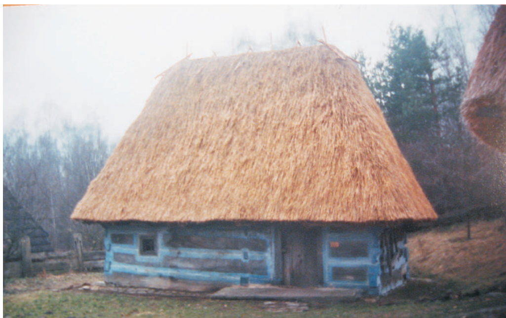
Фото 34: Хата XVII–XVIII ст. зі с. Теремлі Тячівського р-ну Закарпатської обл. Дах покритий соломною “внатрус”. Реставрація 2006 р., НМНАПУ, м. Київ. Фото М. Матійчука
