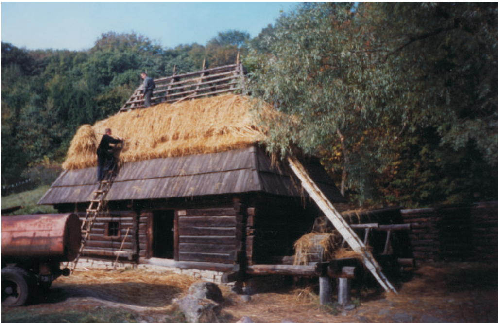
Фото 30: Млин кінця XIX ст. зі с. Пилипця Міжгірського р-ну Закарпатської обл. Процес покриття даху. Реставрація 2006 р., НМНАПУ, м. Київ. Фото М. Матійчука
