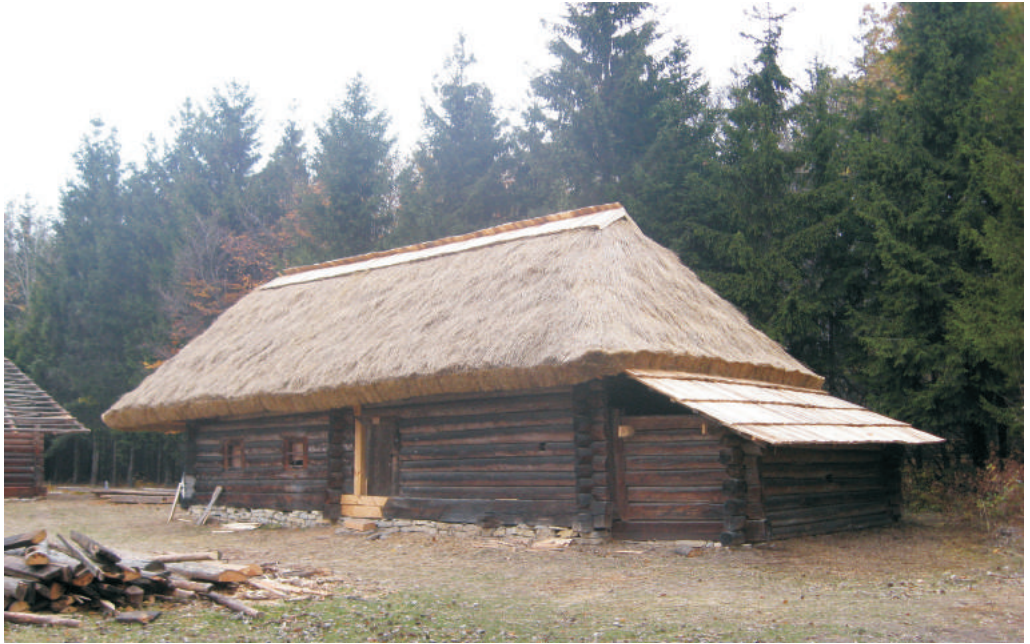
Фото 41: Хата кінця XIX ст. зі с. Липовиці Рожнятівського р-ну Івано-Франківської обл. – після реставрації. Дах покритий сніпками і колоною дошкою. На гребені дерев'яний дашок. Експозиція НМНАПУ, 2010 р. Фото М. Матійчука
