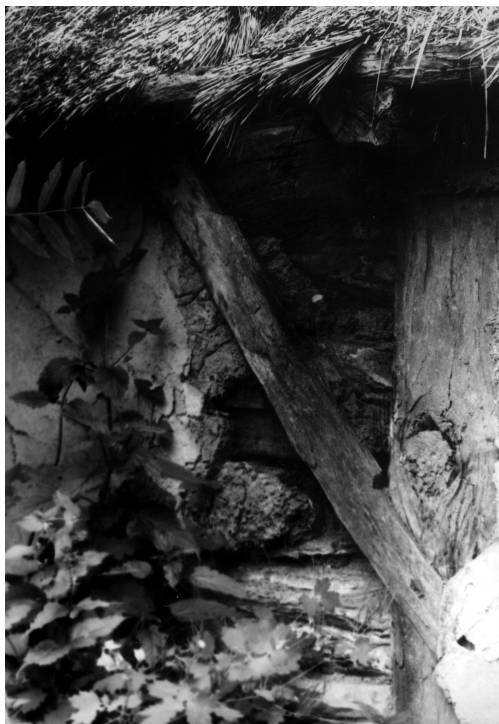
Фото 3. Фрагмент “дильованої” стіни (село Тишків Новоушицького району)
