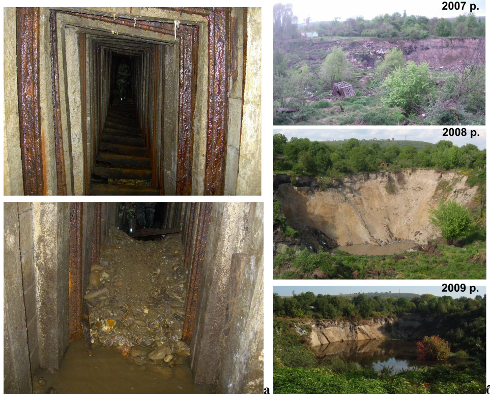
Рис. 5. Деформація дренажної Тиси-штольні в районі Чорного Мочара та вивали у ній четвертинних відкладів, які блокують стік здренованих вод (а); динаміка розвитку соляного карсту (б).
