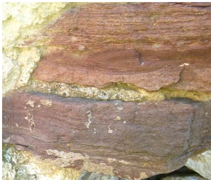
Рис. 9. Руйнування шовного матеріалу, тріщинуватість.
