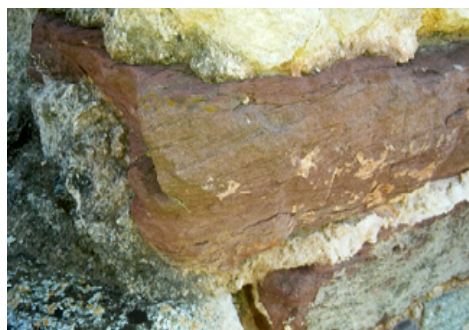
Рис. 10. Темноколірна кірка та тріщини в напрямі по шаруватості.
