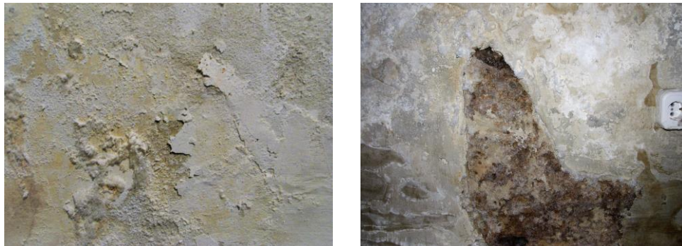
Рис. 1. Висоли на стінах палацу Бандініеллі Fig. 1. Efflorescence on walls of Bandinelli Palace
