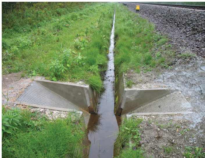
Рис. 3. Перпендикулярний варіант захисної конструкції у дренажному рові.
