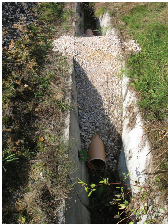
Рис. 4. Трубний варіант захисної конструкції у дренажному рові.
