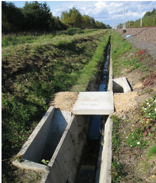
Рис. 2. Паралельний варіант захисної конструкції у дренажному рові.
