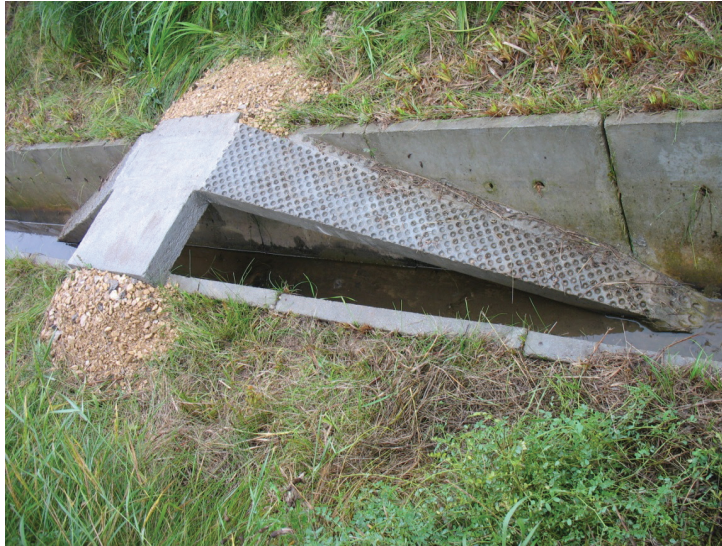
Рис. 5. Внутрішній варіант захисної конструкції у дренажному рові.
