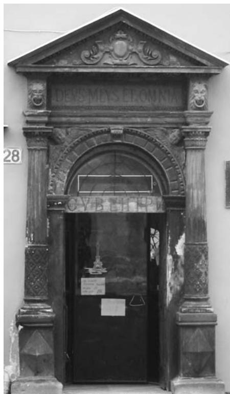
Різьблений портал входу будинку № 28 на Площі Ринок
